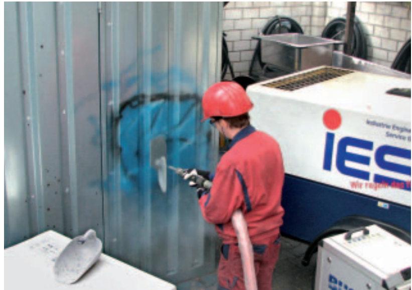
Abb. 14: Trockeneisstrahlen, hier zur Entfernung von Graffiti
