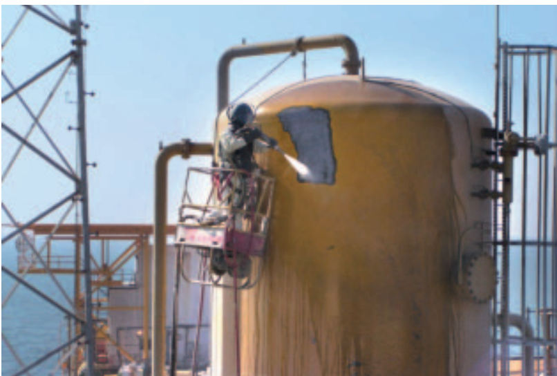
Abb. 4: Entschichtungsstrahlen eines Stahltanks
